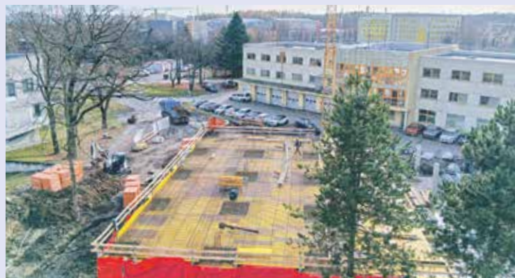
STAVEBNÍ PRÁCE na stavbě jsou v plném proudu
