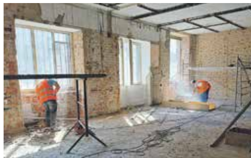
REKONSTRUKCE celého bloku probíhá za plného provozu nemocnice.
