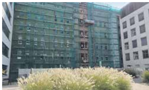
PRACUJE SE TAKÉ na zateplování fasády a výměně oken.
