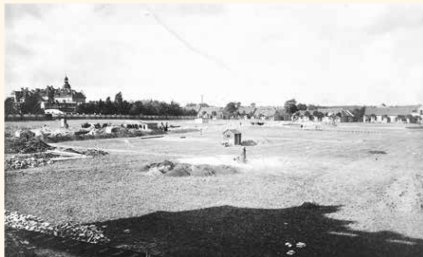
VÝSTAVBA DALŠÍ ČÁSTI nemocnice, rok 1919. Foto: Sládečkovo vlastivědné muzeum Kladno
